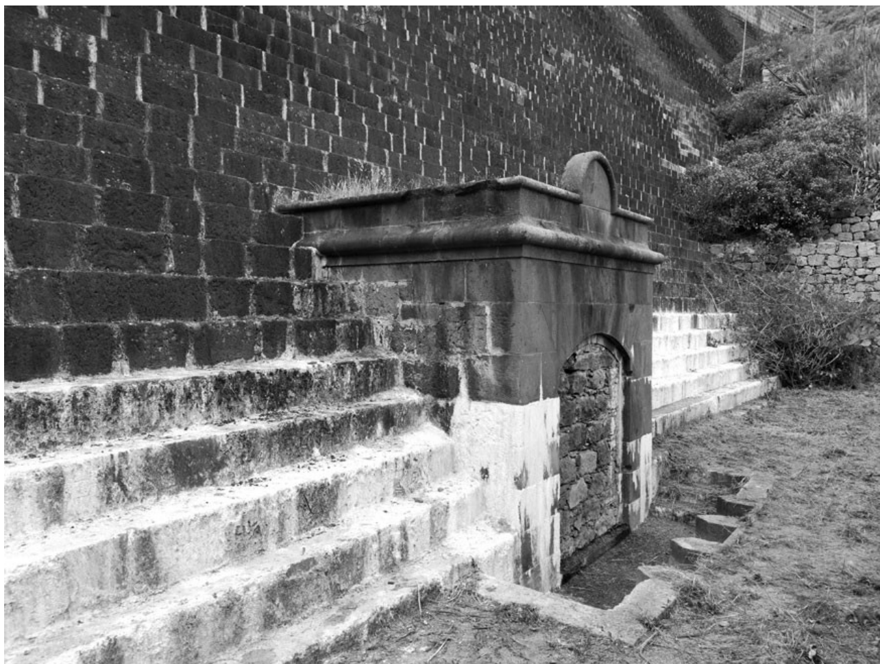
Galería de limpieza de la presa superior (JG)
