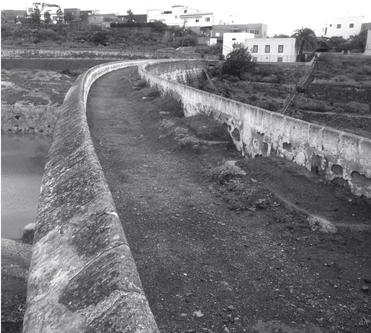
Camino de coronación de La Represa (JG)
