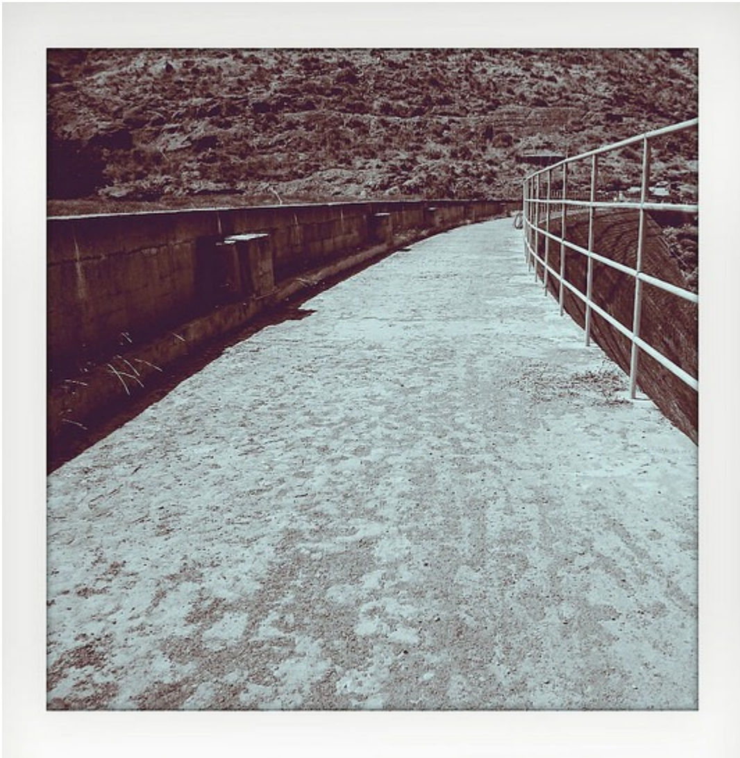
Camino de coronación de la Presa de San Lorenzo
